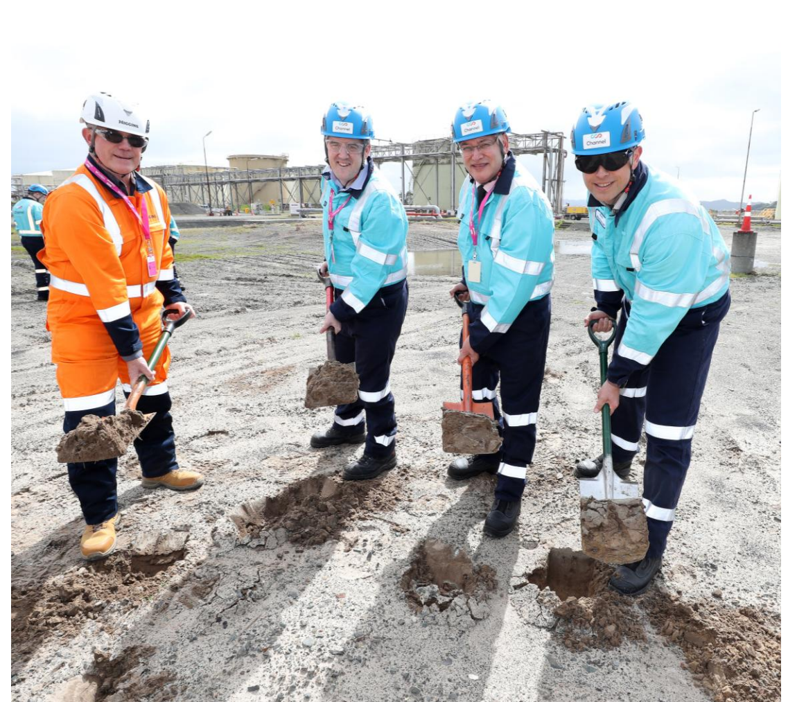
Bitumen Import Terminal
