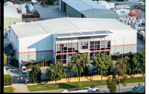
MALAGA DC, PERTH, WA
