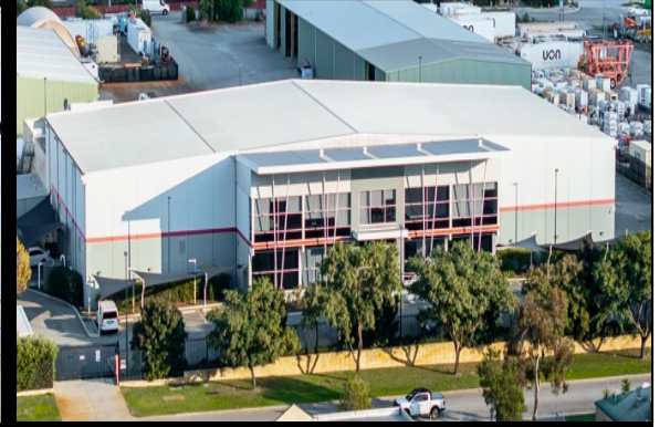
MALAGA DC, PERTH, WA
